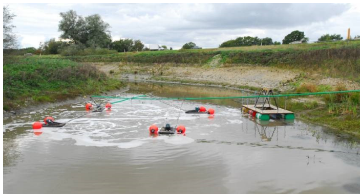
Figur 4.3 Utjämningsmagasin för dagvatten
