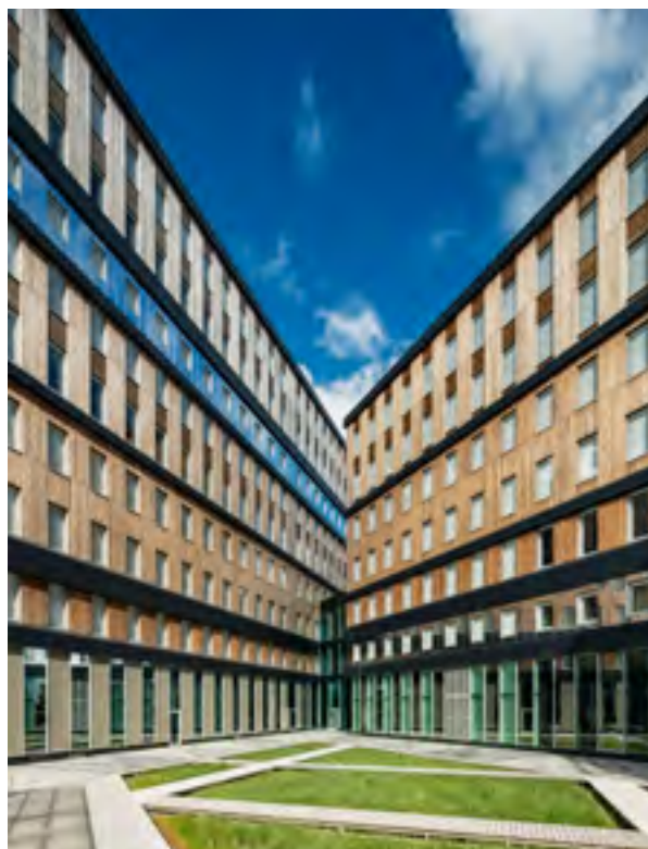
Ett av de miljöprojekt som finansierats med gröna obligationer är den nya BREEAM-certifierade kontorsbyggnaden Sky City Office One på Stockholm Arlanda Airport.
